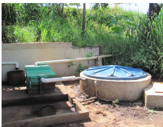
Caixas de separação de água e óleo - SAO
