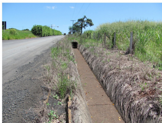
Canal de drenagem da via de acesso interna
