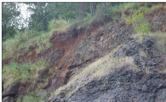
Foto 35: – Frente de lavra da Pedreira Santa Isabel, constituída por basalto, com denso fraturamento vertical. No topo observa-se horizonte de rocha alterada e solo de alteração e residual argiloso raso
